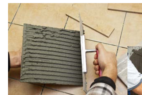
Aplicarea adezivului pe placă
