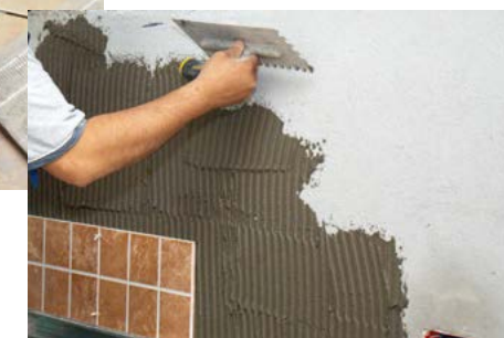
Aplicarea materialului pe suprafața suport
