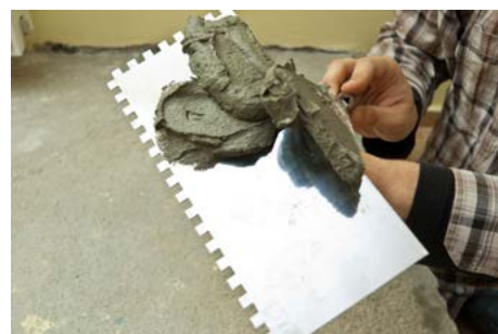
Consistența materialului pe gletieră
