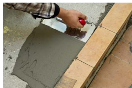
Aplicarea materialului pe suprafața suport
