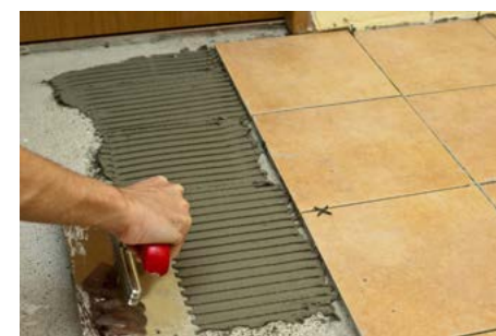
Optimizarea consumului specific prin greblare
