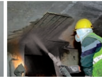
Reparația și protecția structurilor din beton
