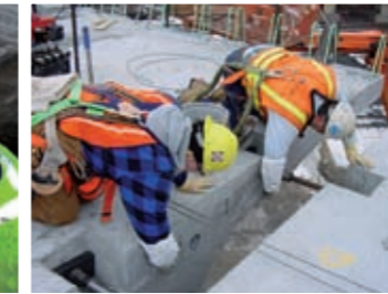
Ancorări și subturnări
