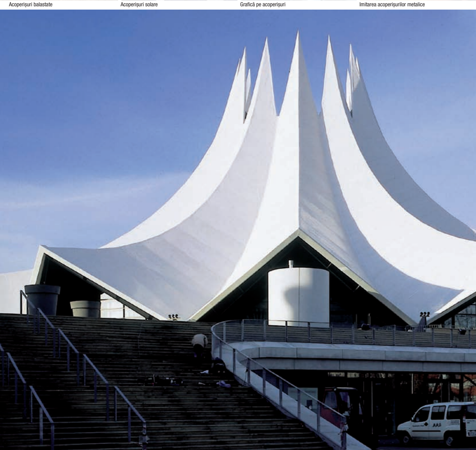
Acoperiș curbat protejat de membrane Sarnafil® Tempodrom, Berlin, Germania
