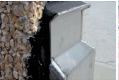
Rosturi de închidere la acoperișuri
