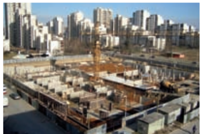
Producția de beton în șantier
