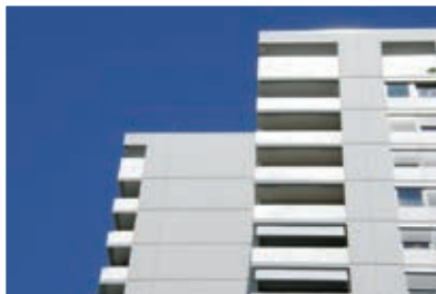
Fațade din beton
