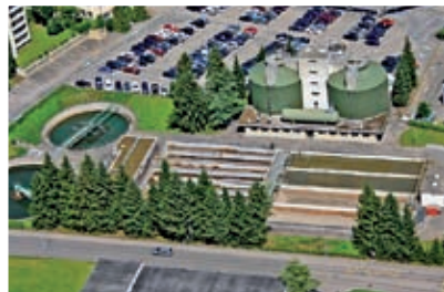
Stații de tratare a apei
