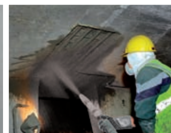
Reparația și protecția structurilor din beton
