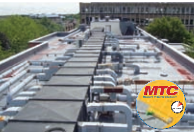
Reparația acoperișurilor cu membrane lichide
