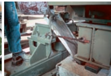
Subturnarea fundațiilor de mașini
