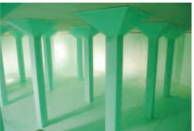
Impermeabilizarea rezervoarelor de apă potabilă
