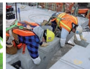
Ancorări și subturnări
