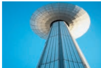
Rezervoare de apă
