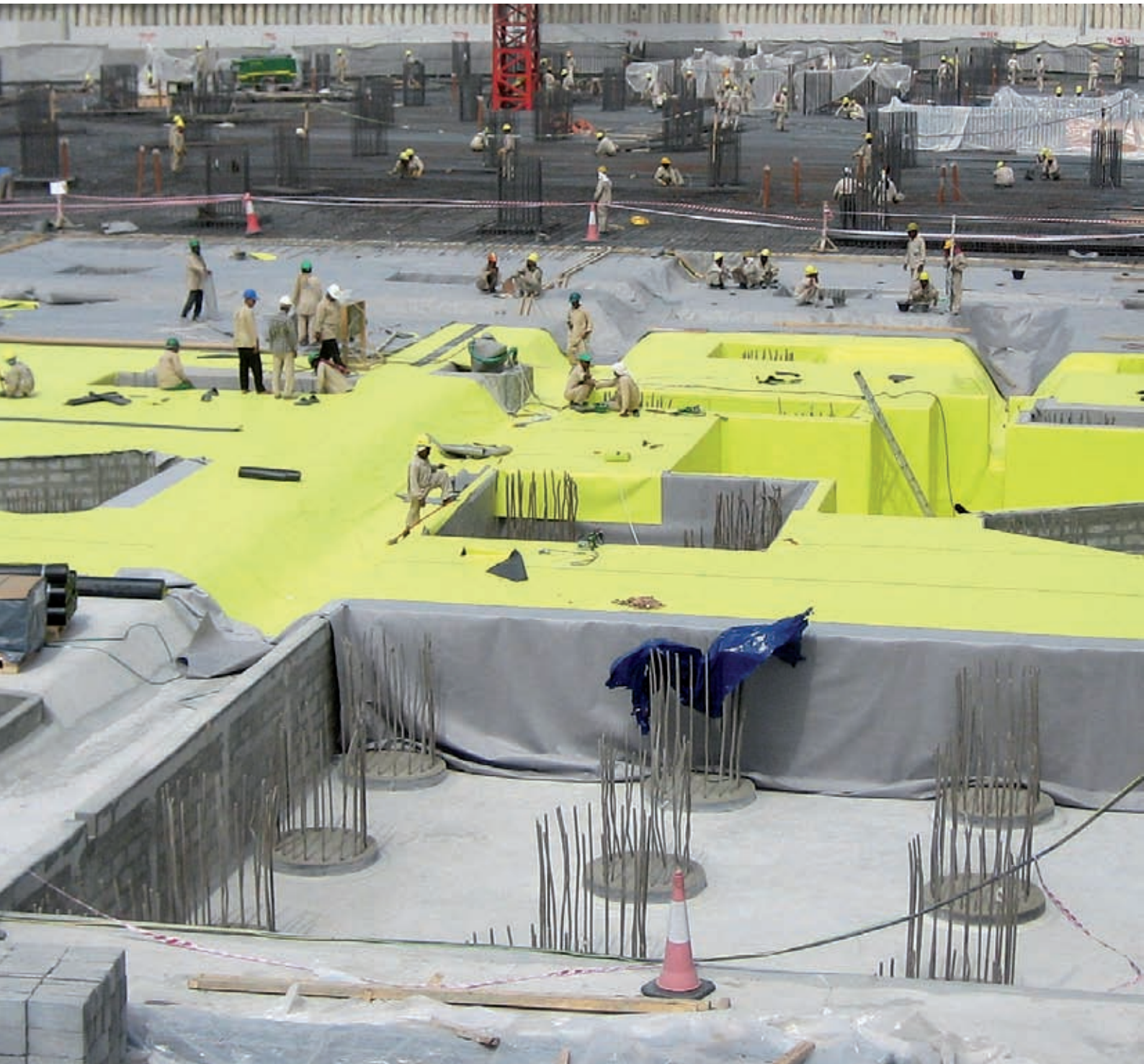
Detalii la membrane hidroizolante
