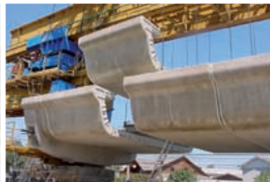
Industria producătoare de prefabricate
